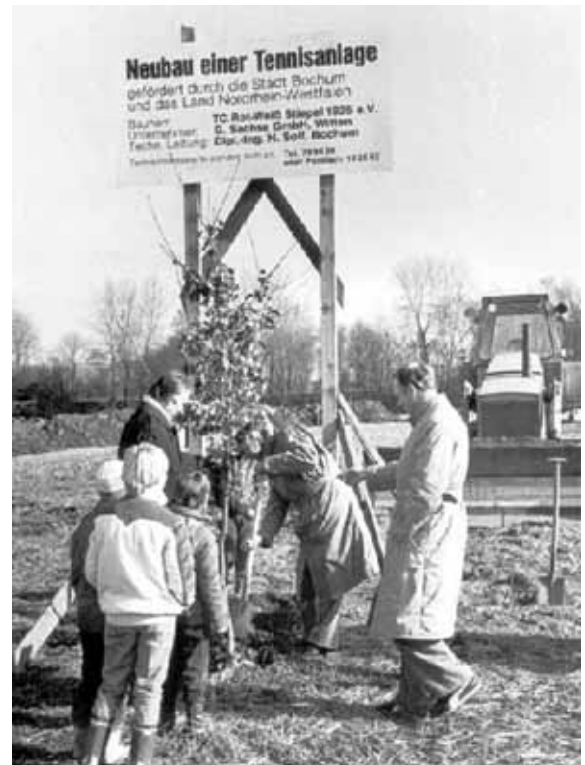
Baubeginn zur neuen Tennisanlage am heutigen Standort 1984.
